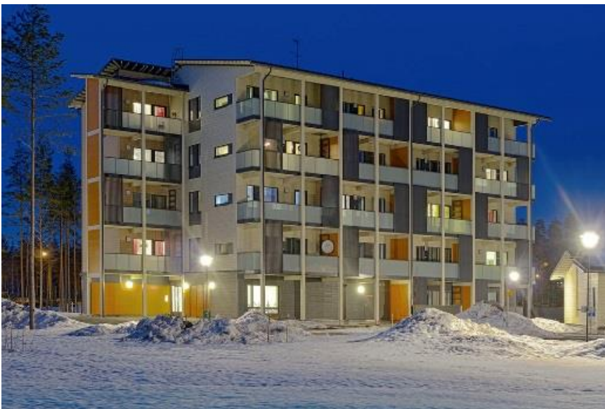
Heinolan vierumäen Puu-Mera. Kuva: Rakennusliike Reponen.
