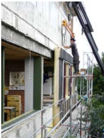
182. Assembly of TES element.
