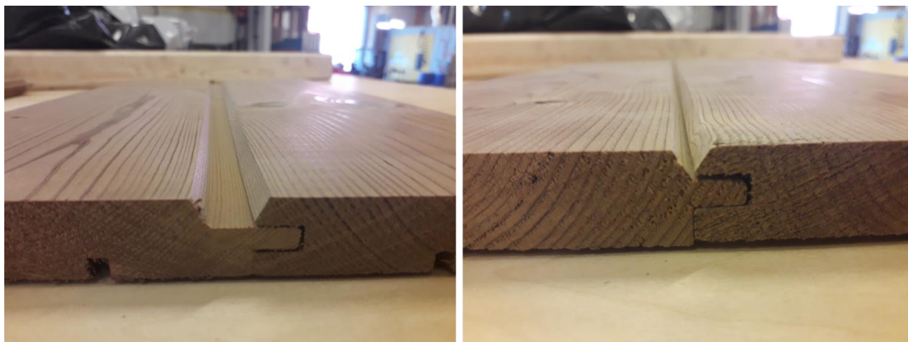
Kuva 5. Vasemmalla UTV profiilin yhtymäkohta ja oikealla TGV paneelin yhtymäkohta.
