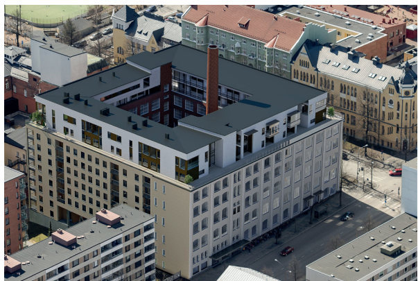
Satamakadun sote-talon katolle on noussut kaksi puurakenteista lisäkerrosta. Kuva: Lujatalo Oy
