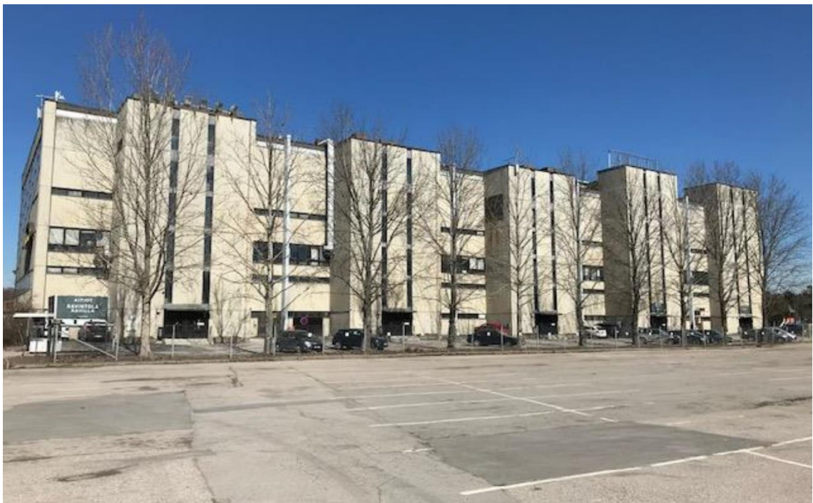
Kuva 3. Katsomorakennuksen umpinainen takajulkisivu. Ojanen Jyrki
