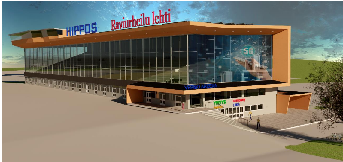
Kuva 21. Rakennuksen pääty toimii isona digitaalisena näyttönä.
