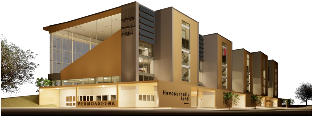
Kuva 13. Sisäänkäyntikatokas kiertää rakennuksen päädyn ja takasivun.
