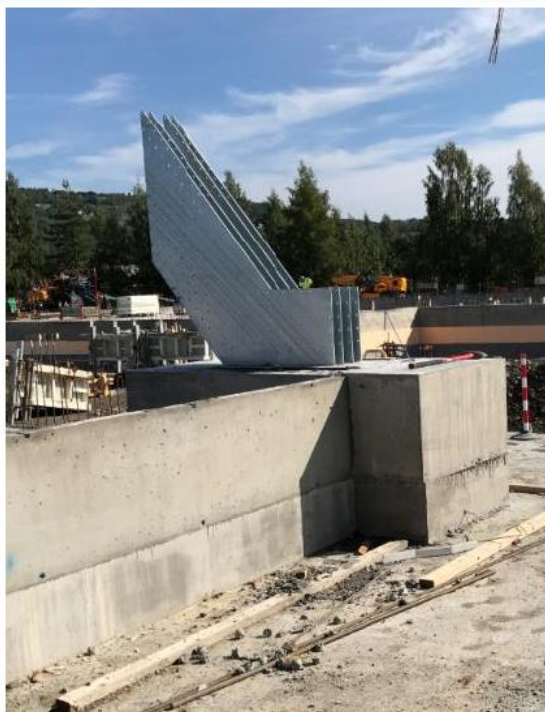
juli 2017 Innstøping av fotbeslag
